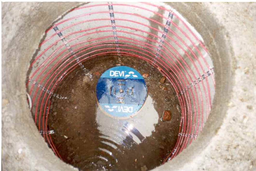
Рис.10. Обогрев бетонного колодца.
