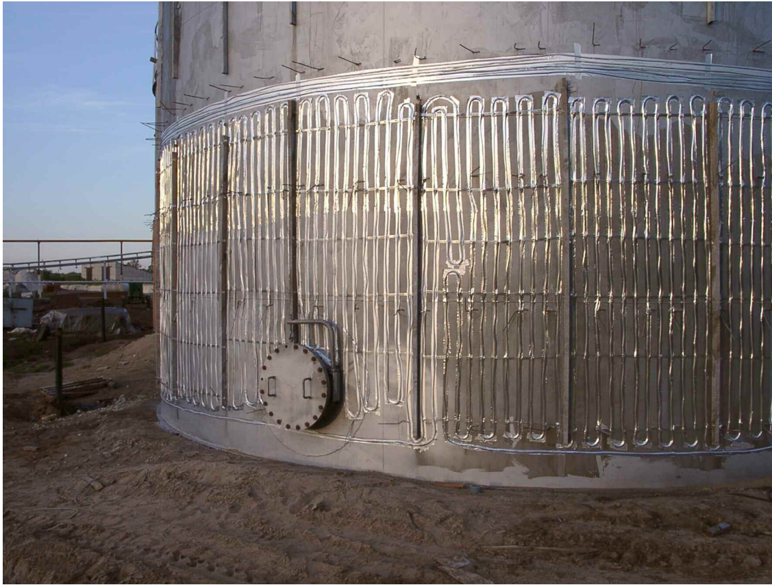
Рис.13. Закрепление нагревательного кабеля липкой лентой alutape на поверхности стенки цистерны.
