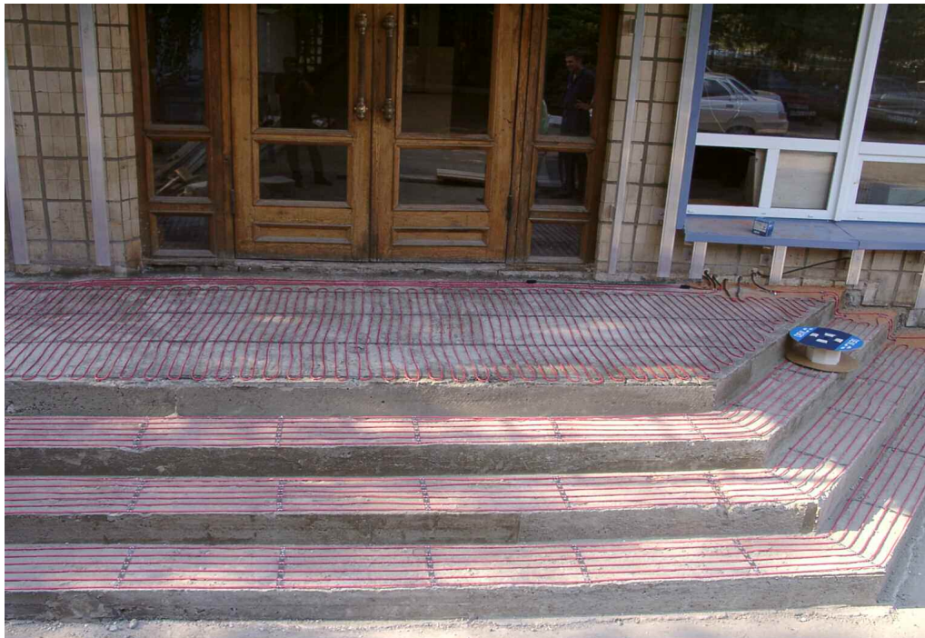
Рис. 9. Применение ленты Devifast™ при монтаже системы обогрева крыльца.
