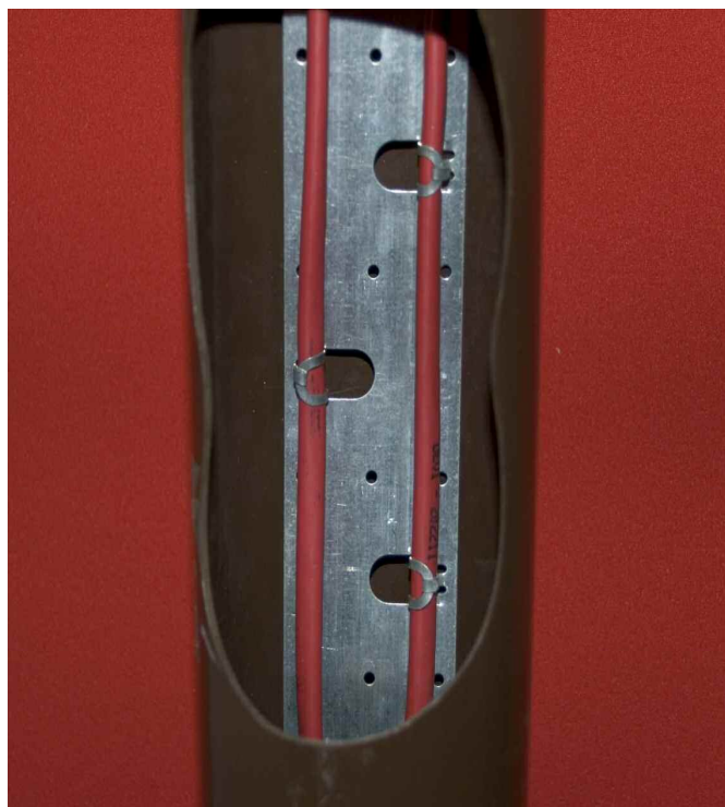
Рис.12. Двойная лента Devifast™ в стандартном вертикальном круглом водостоке.
